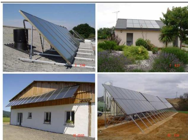
Figure 80 : Différents types d'implantation de panneau solaire thermique (Chambre d'agriculture de l'Aveyron, 2010)
