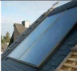
Figure 69 : Capteur plan vitré
