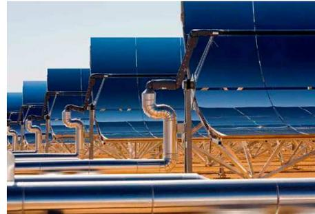
Figure 73 : Capteur à concentration
